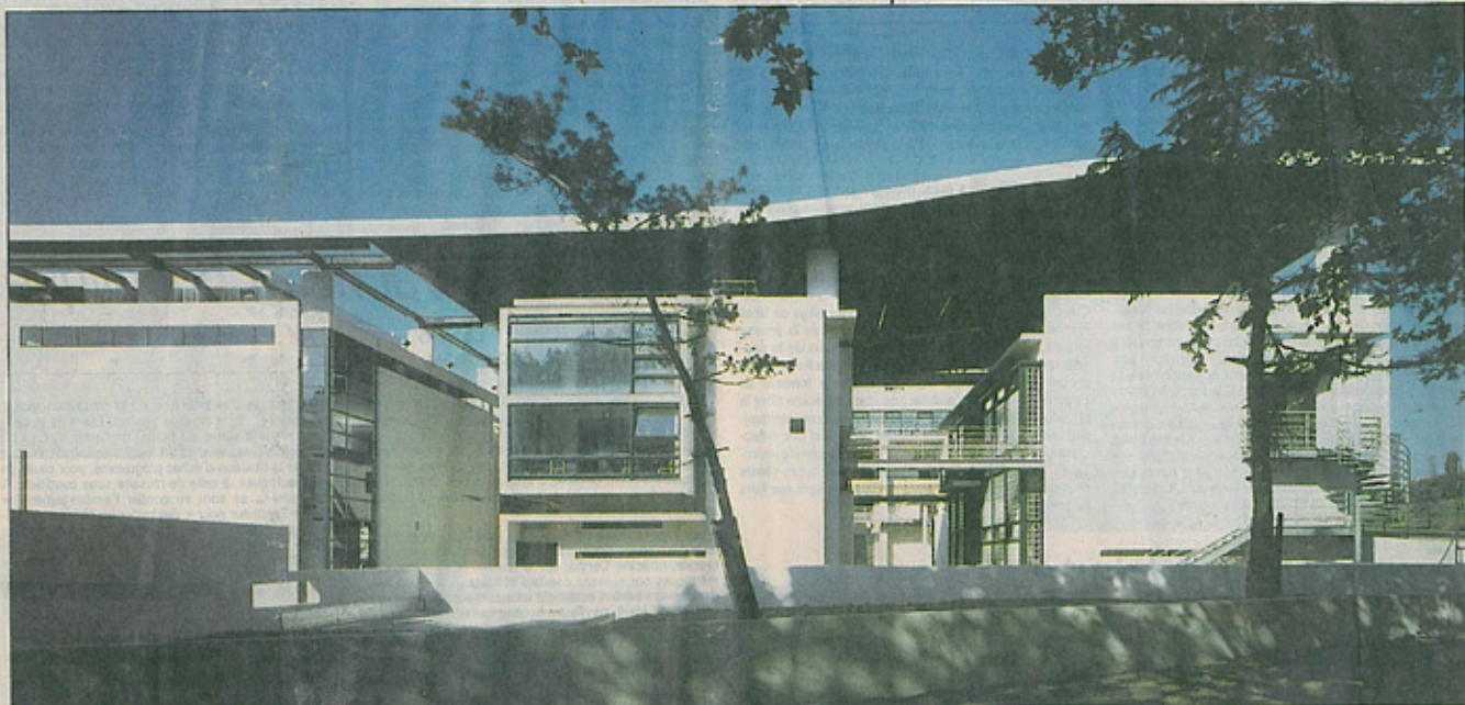
La Cité technique et administrative de la Ville de Paris, quai d'Ivry. Architecte : Michel Kagan
