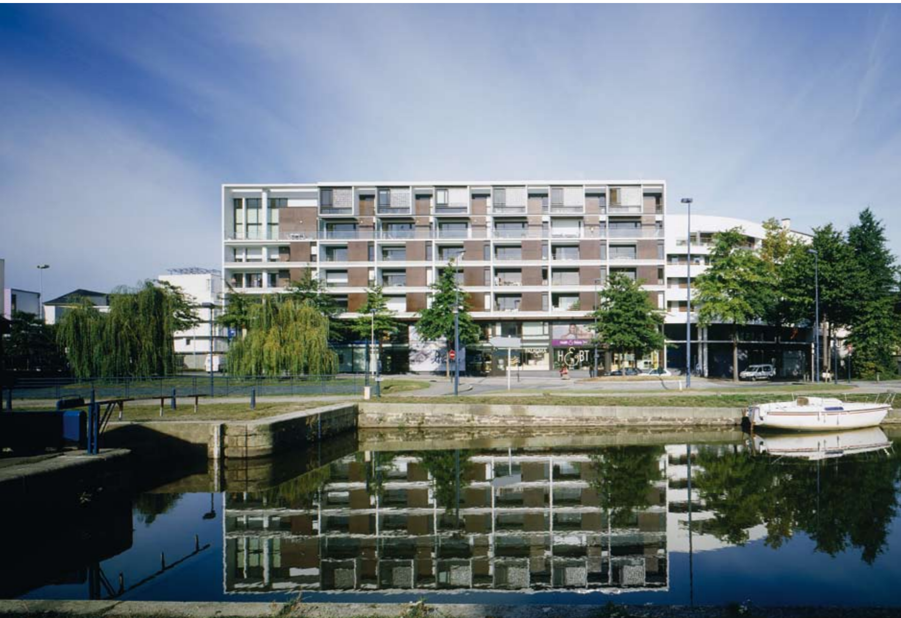
83 logements et commerces à Rennes (35), 2005 Programme : 83 logements en accession à la propriété, 12 commerces et 145 places de parking / Maîtrise d'ouvrage : groupe Giboire OCCL / Coût : 6 381 515 euros TTC / Surface : 8 410 m 2 SHON / © Jean-Marie Monthiers
