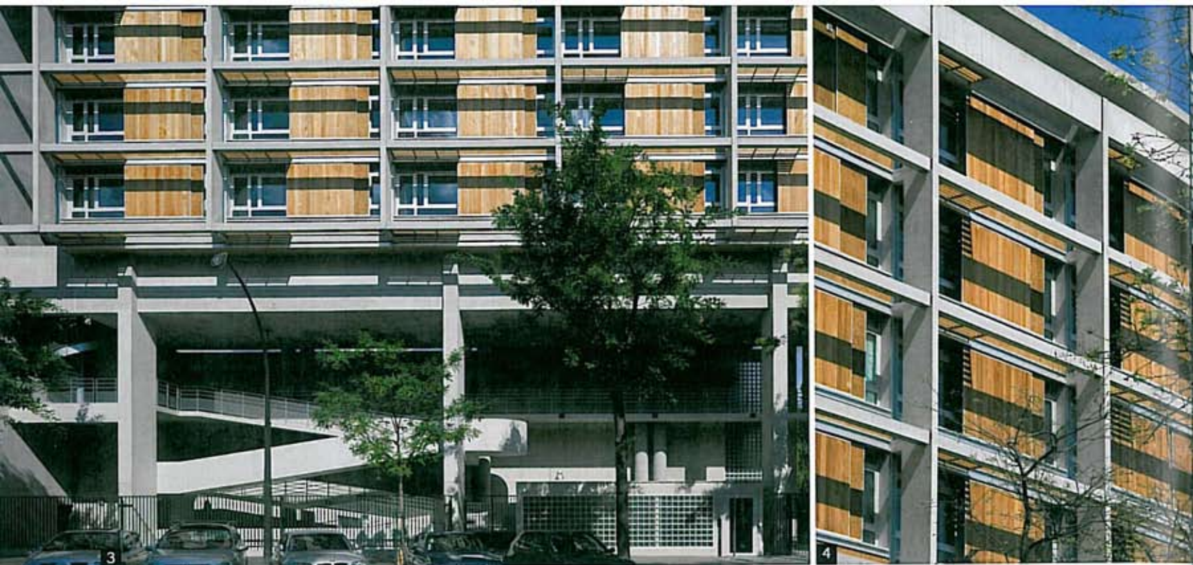
→ 3 • Vue sur la rampe depuis la rue Bruneseau. 4 • Les brises soleil en béton rythmes la façade sud.
